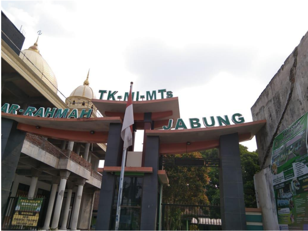
Gambar 5. 8 Gedung MI Ar-Rahmah
